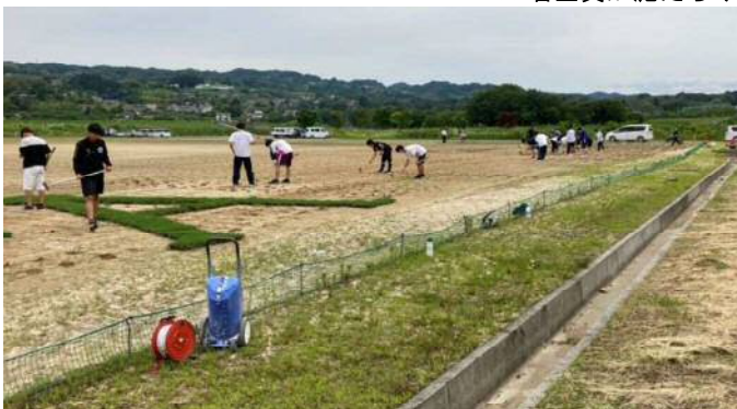
前日の穴開け作業のようす
